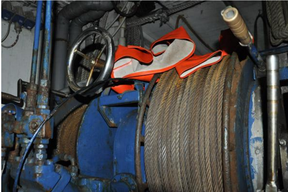
Foto: Das intakte Stahlseil vor dem Auslegen des Netzes
